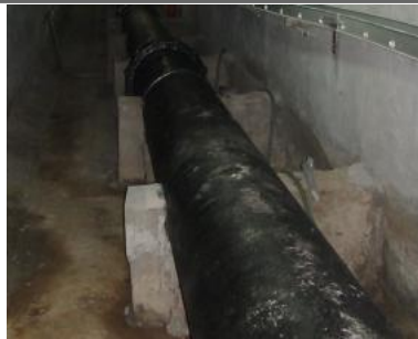
상수관 기초콘크리트 현황
