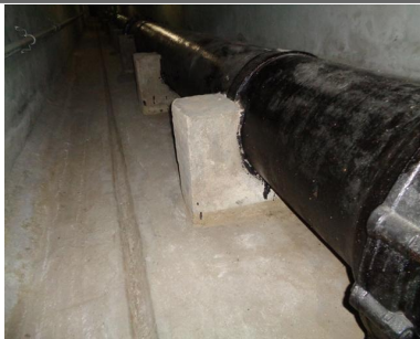
상수관 기초콘크리트 현황
