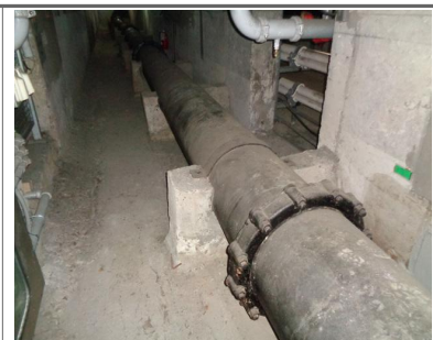
의사당로B 통신구 체수(금회 양호) (STA. 535m~540m)
