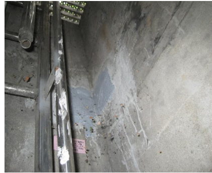
환기구 2번 철근노출 보수
