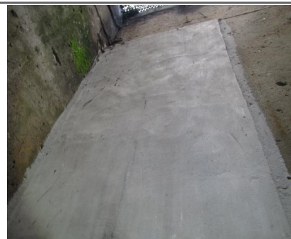
환기구 2번 보수현황(양호)
