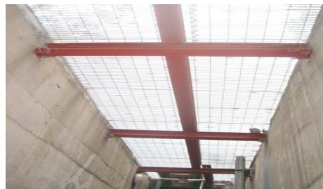
순환선 #15 보강빔 설치 현황(금회)
