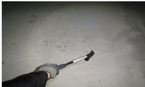
점검망치 타격을 통한 청음조사 전경
