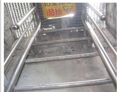
콘크리트 걸침턱 현황
