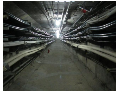
통신관 및 난방관 기초콘크리트 현황
