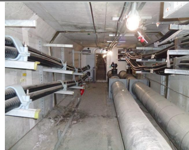
통신관 및 난방관 기초콘크리트 현황
