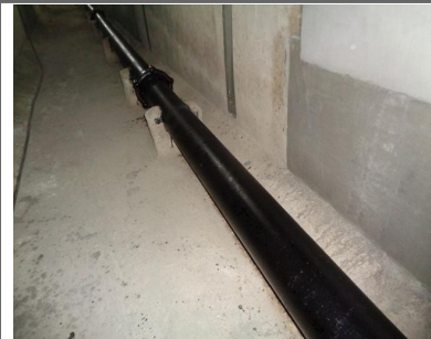
상수관 기초콘크리트 현황
