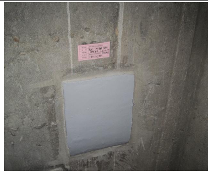
환기구 9번 벽체 철근노출 보수
