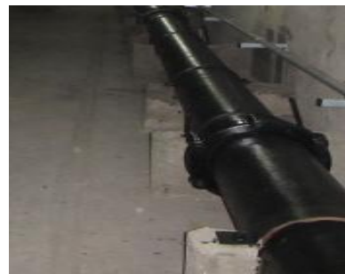
상수관 기초콘크리트 현황
