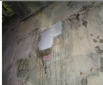
환기구 14번 배면 철근노출 보수
