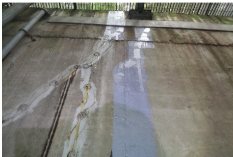
작업구 2번 (재)균열 보수
