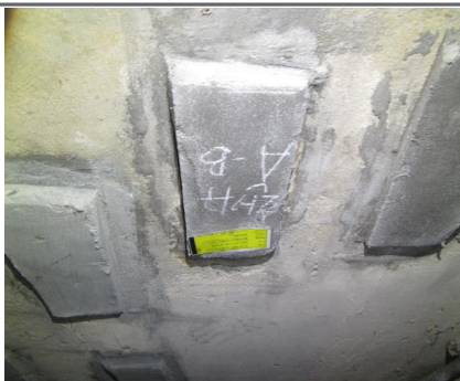
환기구 2번 보수현황(양호)
