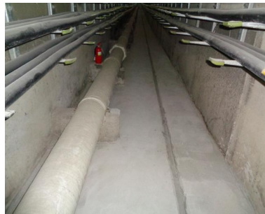
상수관 기초콘크리트 현황
