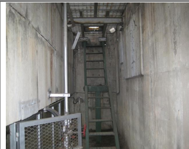
내부 작업구 점검계단 현황
