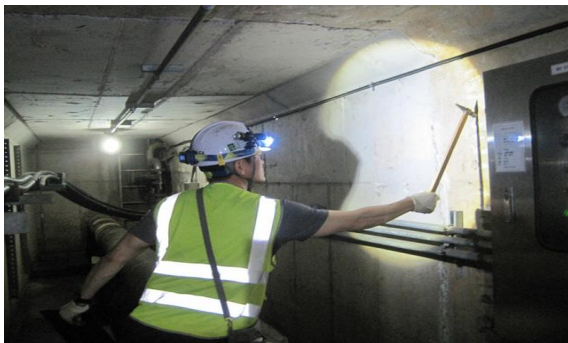
점검망치 타격을 통한 보수부 상태 조사 전경
