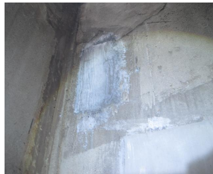
환기구 8번 철근노출 보수
