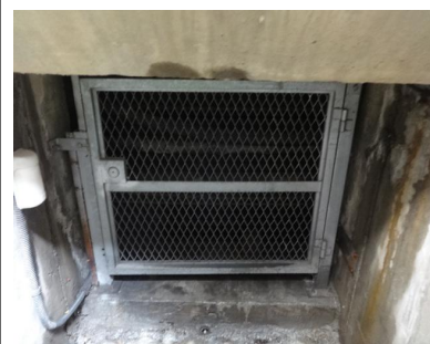
환기구 내부 잠금장치 현황
