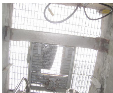
콘크리트 걸침턱 현황
