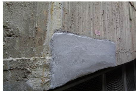
작업구 4번 철근노출 보수
